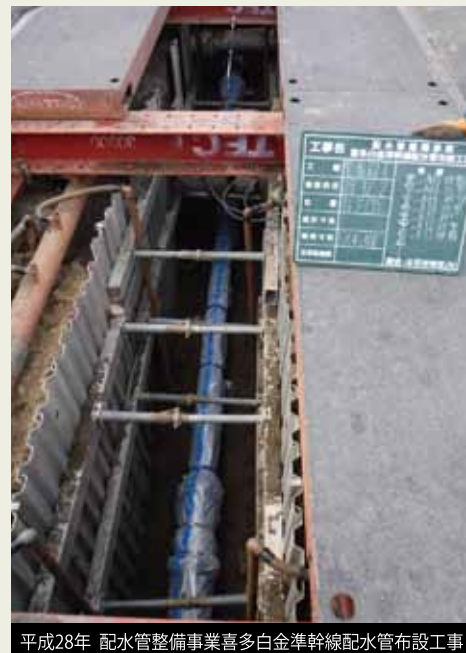
平成28年 配水管整備事業喜多白金準幹線配水管布設工事
