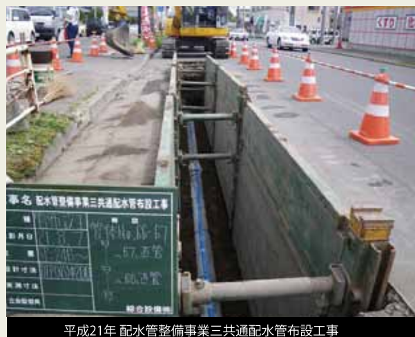
平成21年 配水管整備事業三共通配水管布設工事
